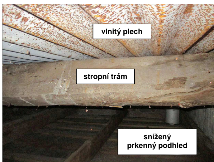
foto 10: Pohled do prostoru stropu nad 2.NP v místě sondy P-5
