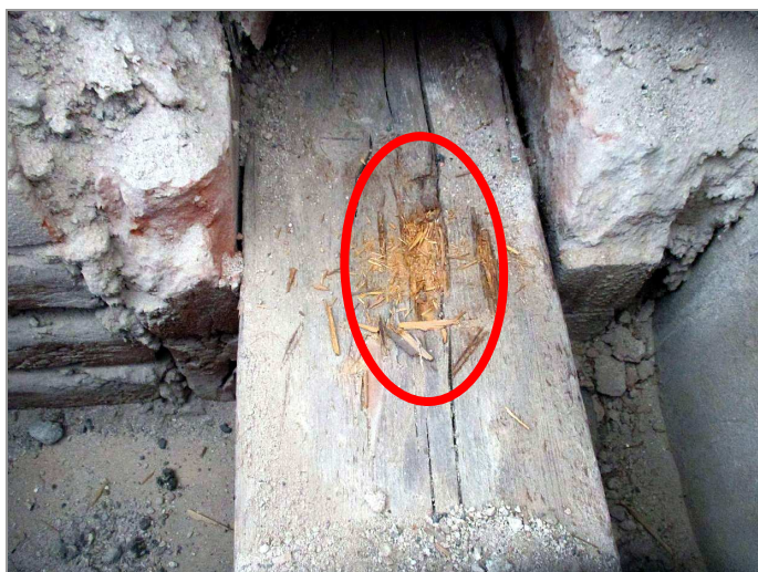
foto 3: Detail hnilobou slabě poškozeného zhlaví v sondě P-2
