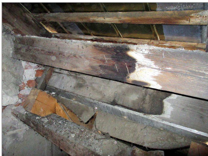
foto 18: Zatékáním povrchově poškozená vaznice krovu
