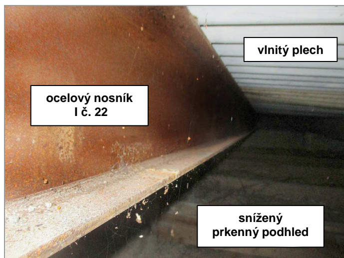
foto 11: Detail ocelového nosníku stropu nad 2.NP v sondě P-5
