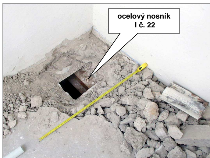
foto 9: Sonda P-5 v podlaze 3.NP/podkroví
