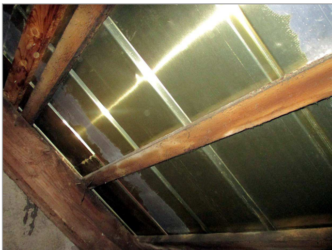
foto 17: Detail laťování a plechové střešní krytiny
