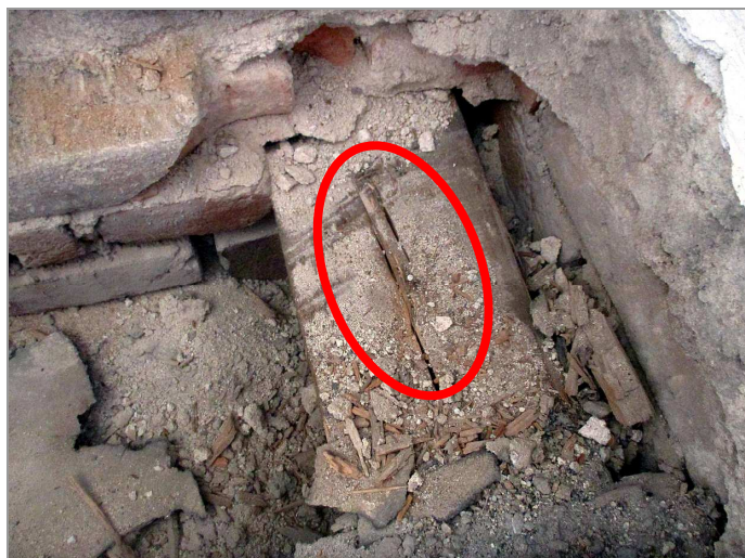
foto 7, 8: Detail hnilobou slabě poškozeného trámového zhlaví resp. hnilobou a hmyzem poškozeného prkna záklopu v sondě P-4
